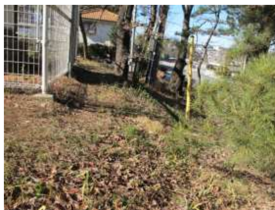
柳瀬公民館 法面
