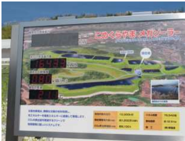
発電所出力表示器
